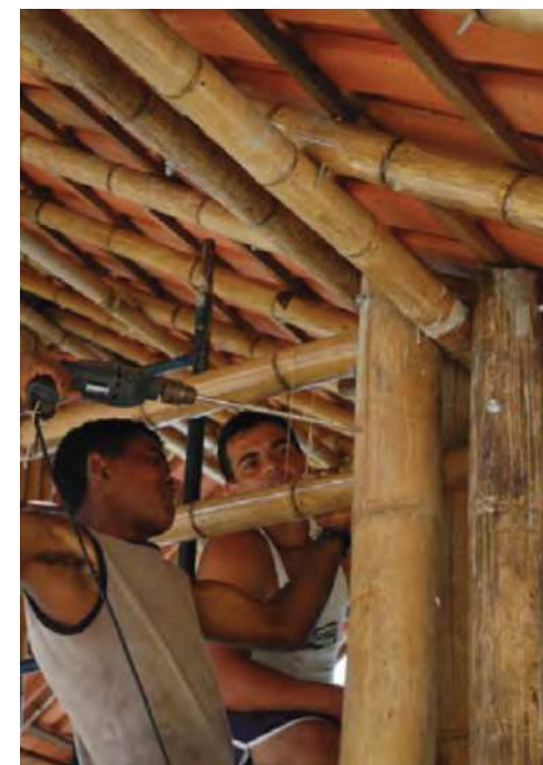
Figura 09: Montagem Estrutura em Bambu Fonte: NASS, Mirella
